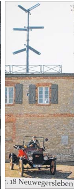
So hat die Telegrafenstation in Neuwegersleben ausgesehen.
