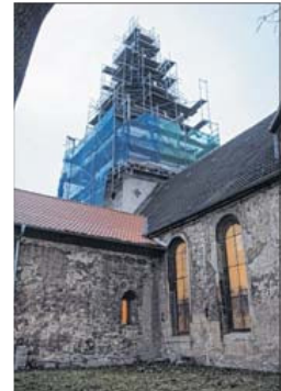
Der Kirchturm ist bereits seit August eingerüstet. Nach einer Pause wird nun weitergearbeitet.
